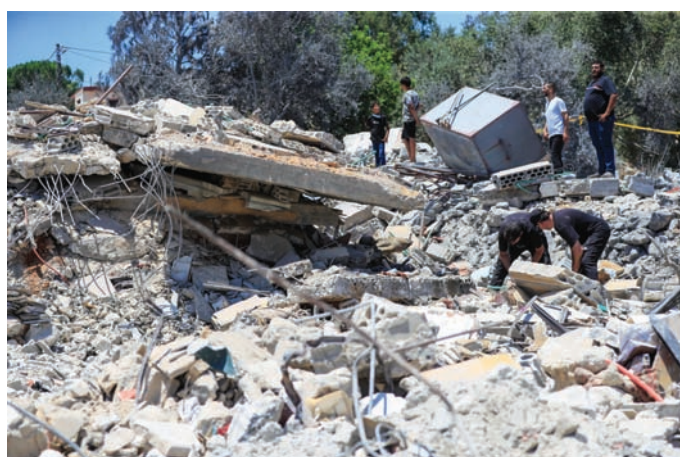
مبنى مدمر في بلدة الجيمجمة جنوب لبنان استهدفه القصف الإسرائيلي مساء الخميس الماضي (أ.ب)
