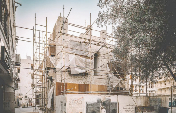
مبنى قيد الترميم في جدة التاريخية (واس)
