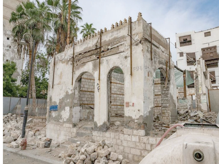
أحد المباني أثناء عملية الترميم (واس)
