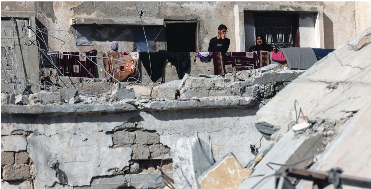
فلسطينيون يتفقدون الأضرار التي لحقت بمبنى استهدف في غزة إسرائيلية برقع جنوب قطاع غزة أمس (أ.ف.ب)
