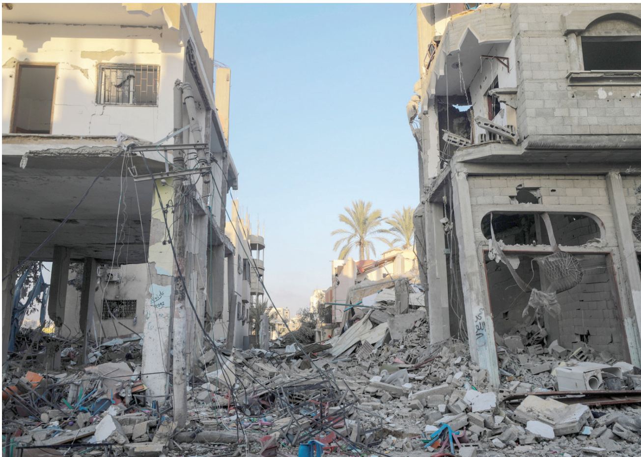
منازل مدمرة في مخيم المغازي للاجئين خلال العملية العسكرية الإسرائيلية في جنوب قطاع غزة (أ.ب.أ.)
