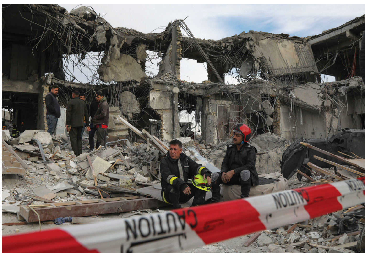
مبنى متضرر جراء الهجوم الصاروخي الإيراني على أربيل (أ.ف.ب)
