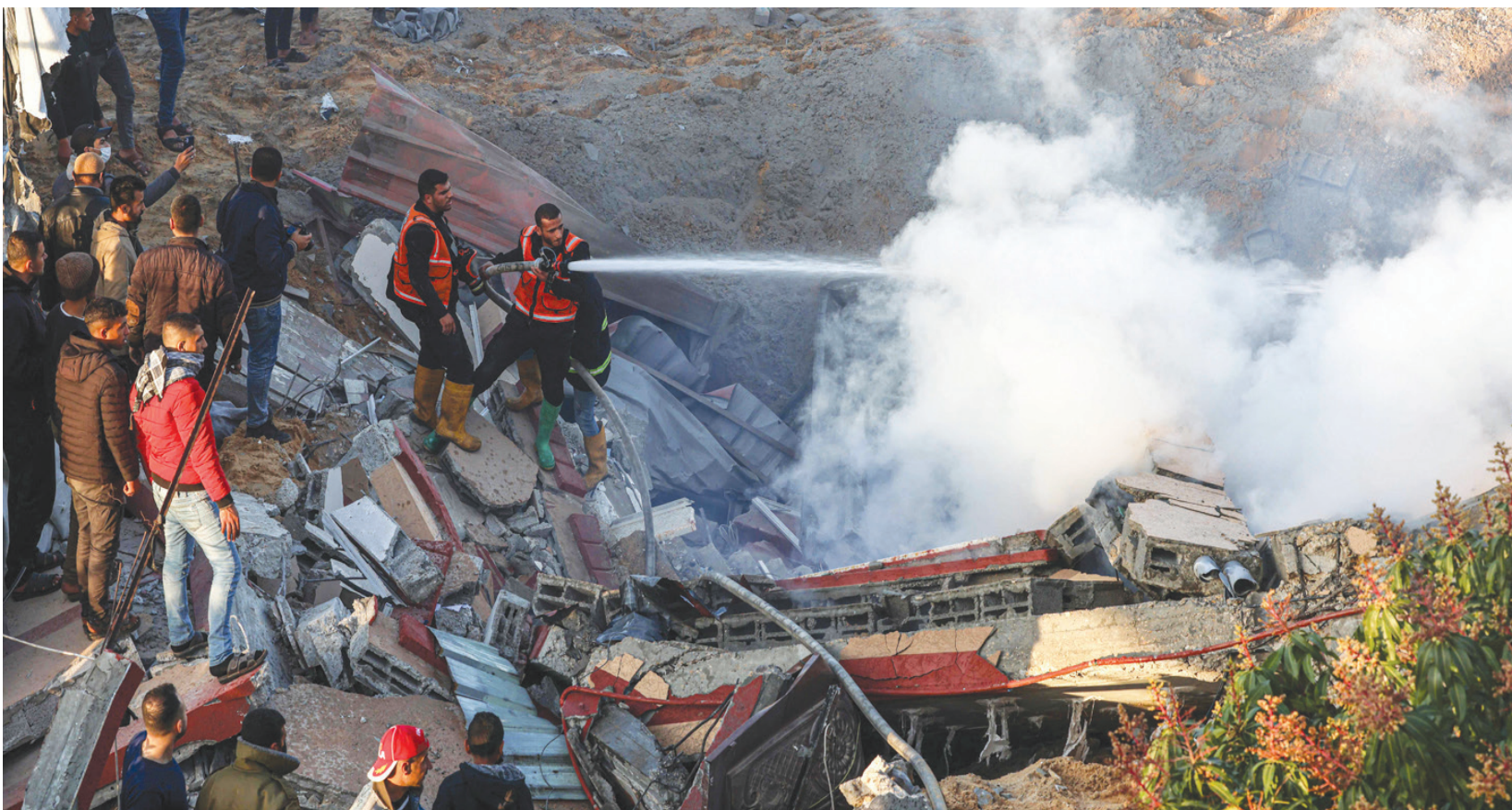
أفراد من الدفاع المدني الفلسطيني يطفئون حريقاً أمس في مبنى شرق رفح جنوب قطاع غزة (أ.ف.ب)
