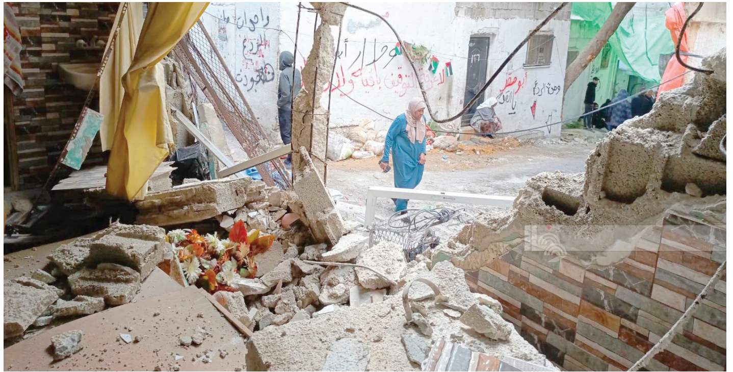
آثار الدمار الذي أحدثه هجوم الجيش الإسرائيلي الأخير على طولكرم ومخيم نور شمس بالضفة (وفا)
