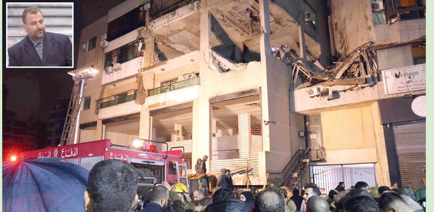
عناصر من الدفاع المدني اللبناني أمام مبنى مكتب «حماس» الذي استهدفته إسرائيل في ضاحية بيروت الجنوبية أمس (أ.ف.ب)... وفي الإطار صورة العاروري الذي قضى في الهجوم (إ.ب.أ)
