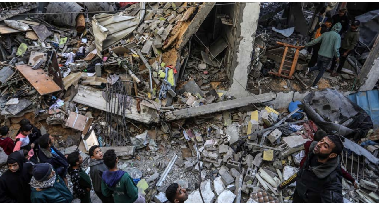
فلسطينيون يتفقدون مبنى مدمراً تابعاً لعائلة أبو العوف بعد غارة جوية إسرائيلية على رفح في جنوب قطاع غزة (د.ب.أ)
