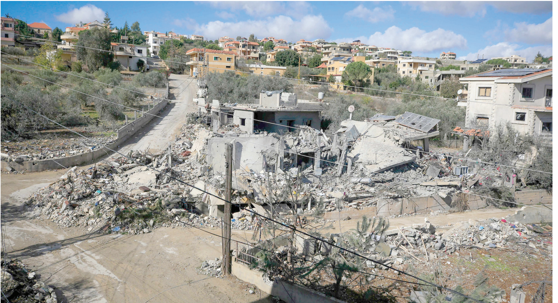
منزل مدمر نتيجة القصف الإسرائيلي على بلدة عيترون بجنوب لبنان (أ.ف.ب)
