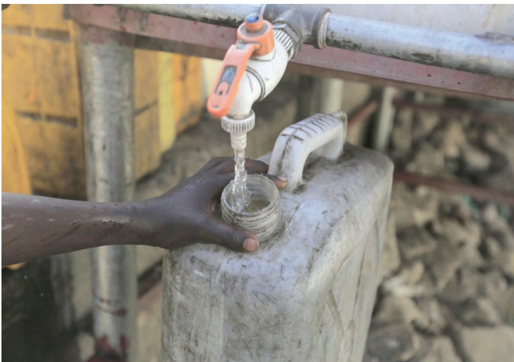
الحصول على المياه النظيفة مهمة صعبة في اليمن... أهالي صنعاء يحصلون على ماء صالح للشرب من أحد الأنابيب الموصولة بخزان (إ.ب.أ)
