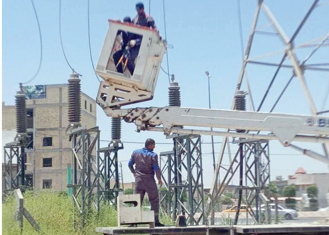
صورة من صفحة وزارة الكهرباء العراقية في «فيسبوك» لفنيين يصلحون إحدى شبكات الكهرباء
