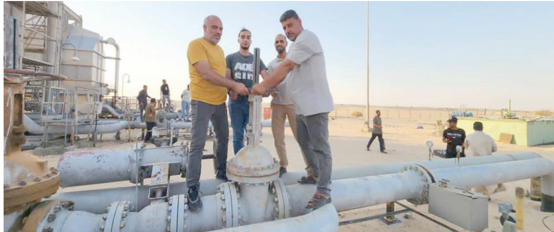
ليبيون غاضبون بغلقون حقل «108» النفطي (جهاز حرس المنشآت النفطية بالجنوب الشرقي)
