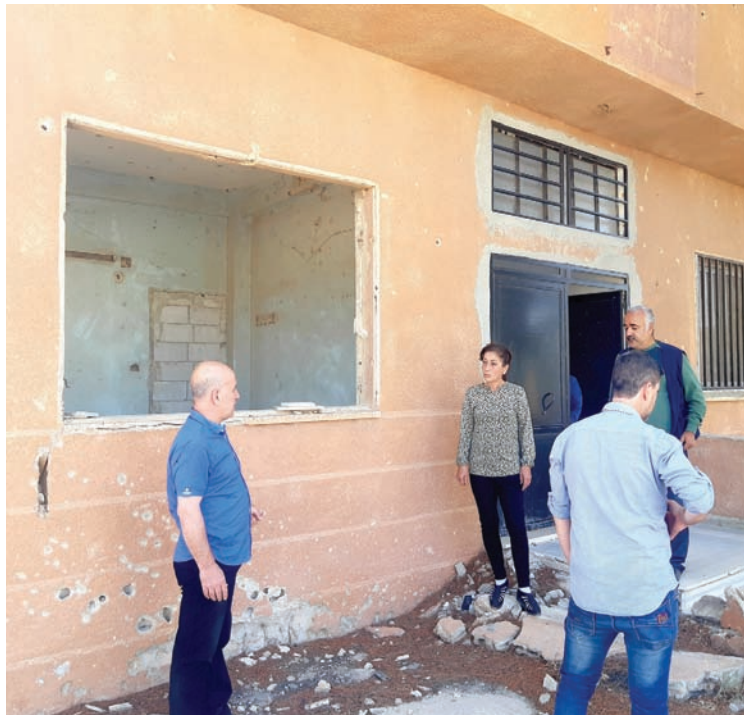
عائلة عادت إلى ترميم منزلها في القصير (الشرق الأوسط)
