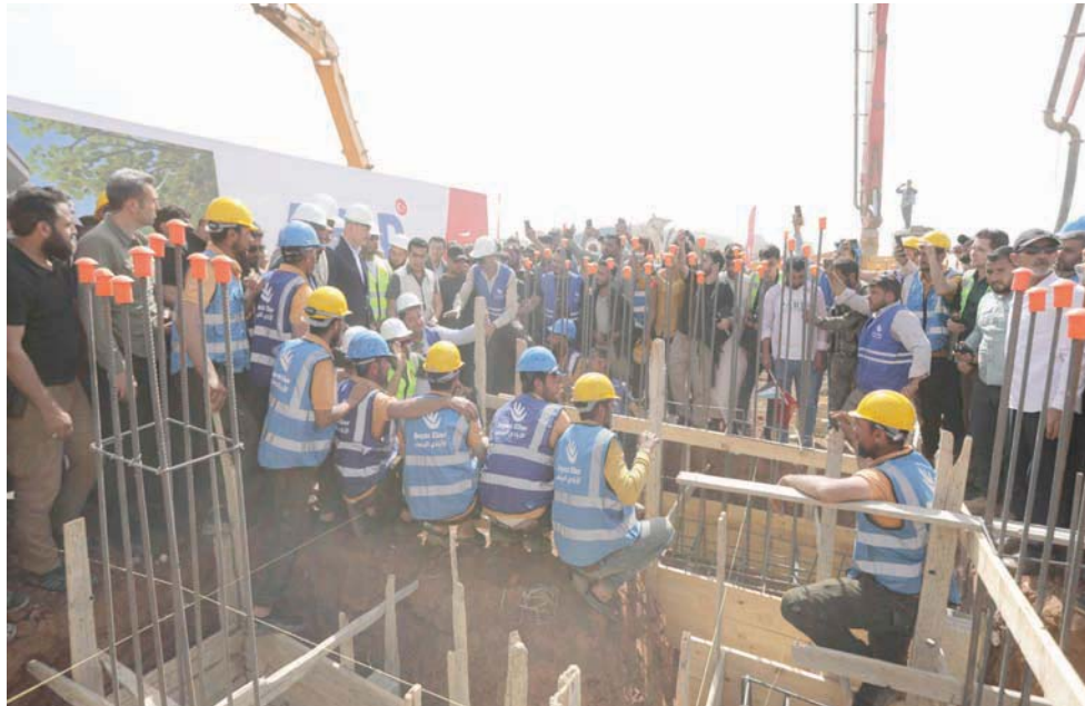
من أعمال بناء بيوت للاجئين في جرابلس (أ.ف.ب)
