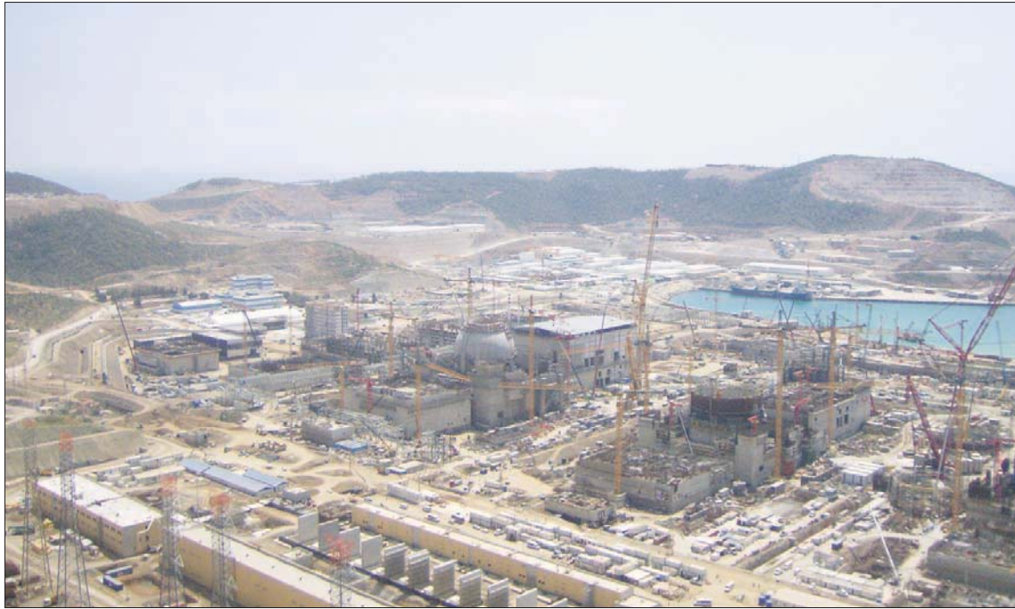
موقع بناء محطة «أكويو» ويظهر المفاعل الأول الذي جرى تسليم الوقود النووي الخاص به (الشرق الأوسط)
