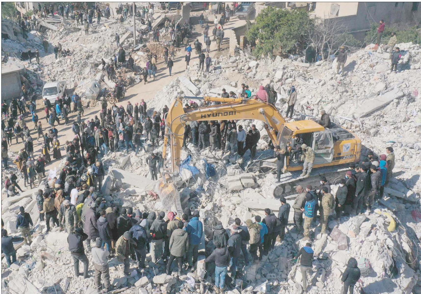
مسعفون ورجال إنقاذ في موقع مبنى تهدم جراء الزلزال في حارم بريف إدلب أمس (أ.ب)
