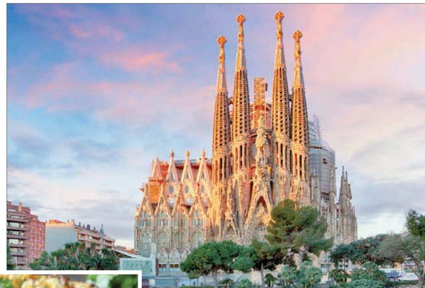
كنيسة «ساغرادا فاميليا» التي لا تزال في طور البناء
