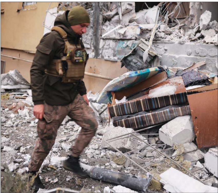
جندي أوكراني يمر أمام مبنى مدمر بفعل صاروخ في خيرسون أمس (رويترز)
