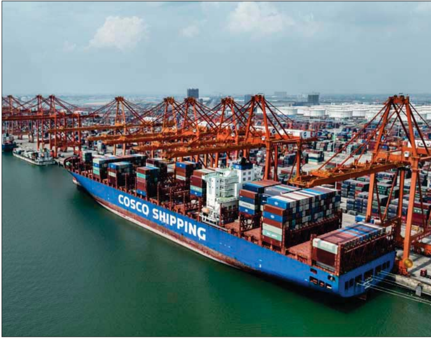
سفينة حاويات في ميناء تشينغتشو بمنطقة قوانغشي جنوب الصين (أب)
