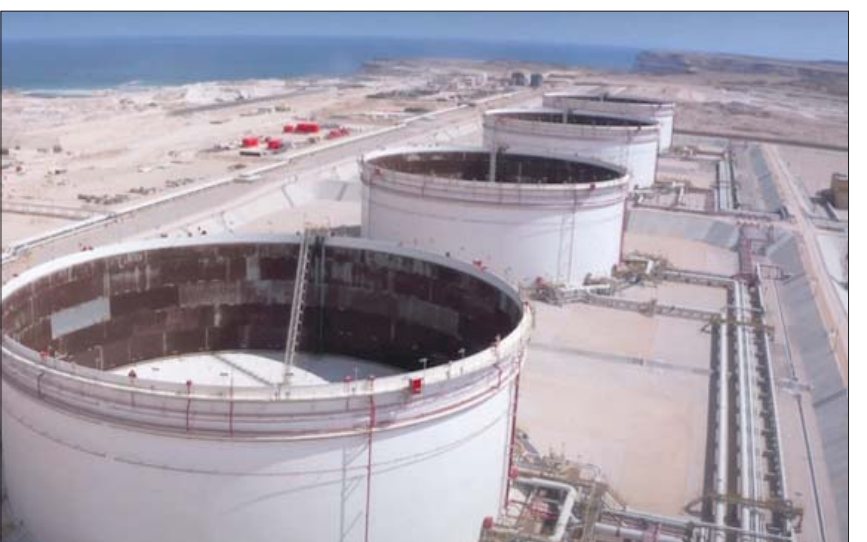
صهاريج نفط في طور الإنشاء بحقل عماني (وكالة الأنباء العمانية)
