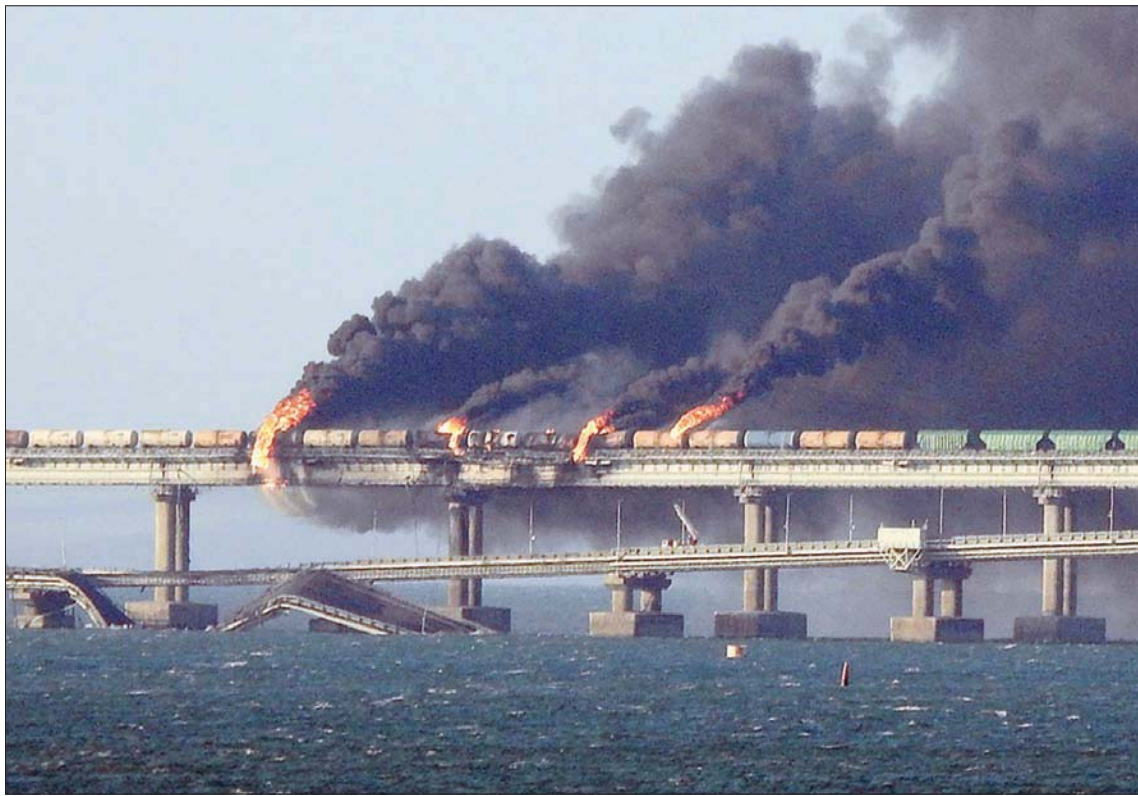
اشتعلت النيران بفعل التفجير في 7 خزانات وقود على طول خط السكك الحديدية الذي يمر بالقرب من ممر السيارات ونجح رجال الإنقاذ خلال ساعات النهار في إخماد الحريق بعدما تم تعليق حركة المرور على الجسر مؤقتاً (أ.ف.ب)
