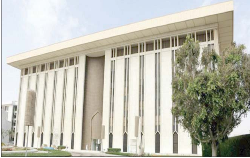
البنك المركزي (الشرق الأوسط)
