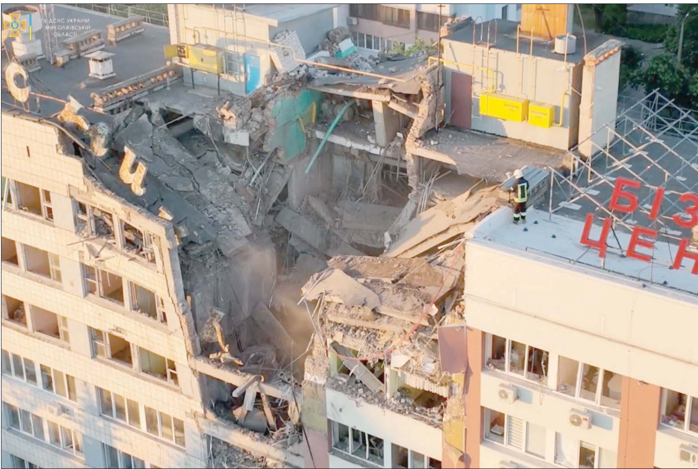
رجل إطفاء أوكراني على سطح مبنى دمر جزء منه بقصف روسي قبل أيام (رويترز)
