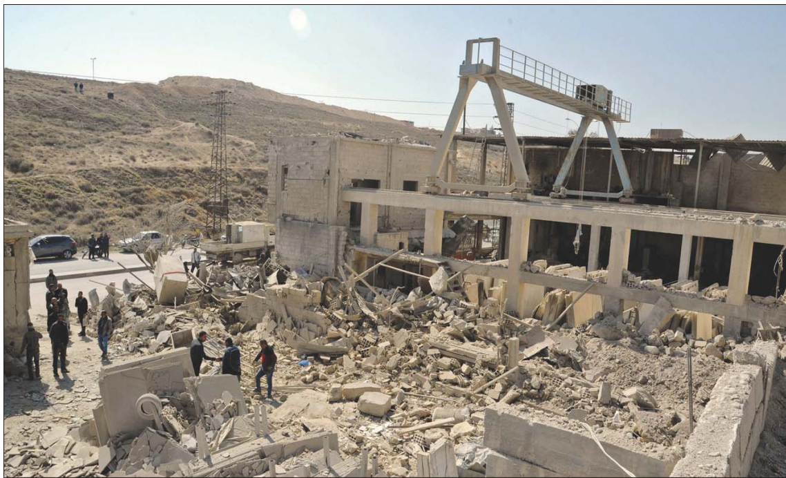
تفقد مبنى مدمر في أعقاب قصف صاروخي إسرائيلي لمواقع في جنوب العاصمة دمشق (أ.غ.ب)
