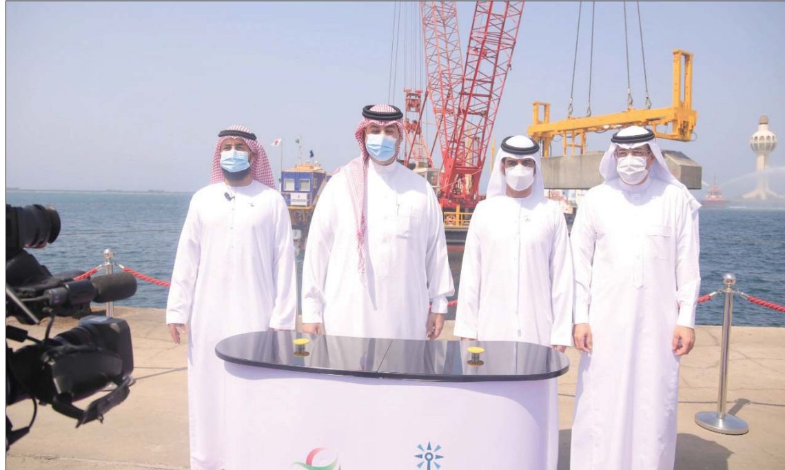
جانب من مراسم تدشين أعمال إنشاءات تطوير محطة الحاويات الجنوبية بميناء جدة الإسلامي (الشرق الأوسط)
