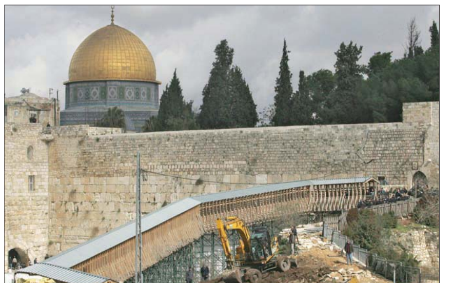
أعمال حفر لجسر يؤدي إلى بوابة باب المغاربة في مجمع الأقصى فبراير 2007 (فيتي)
