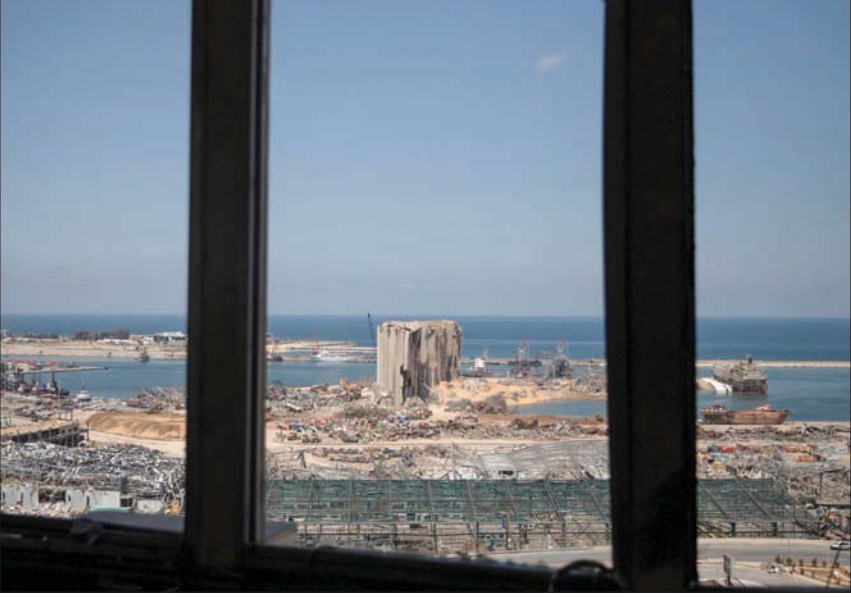
المرفأ بعد التفجير من مبنى كهرباء لبنان (رويترز)
