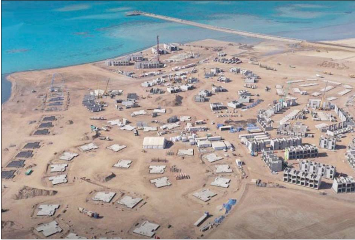
جانب من أعمال البناء والتأسيس في «مشروع البحر الأحمر» غرب السعودية (الشرق الأوسط)
