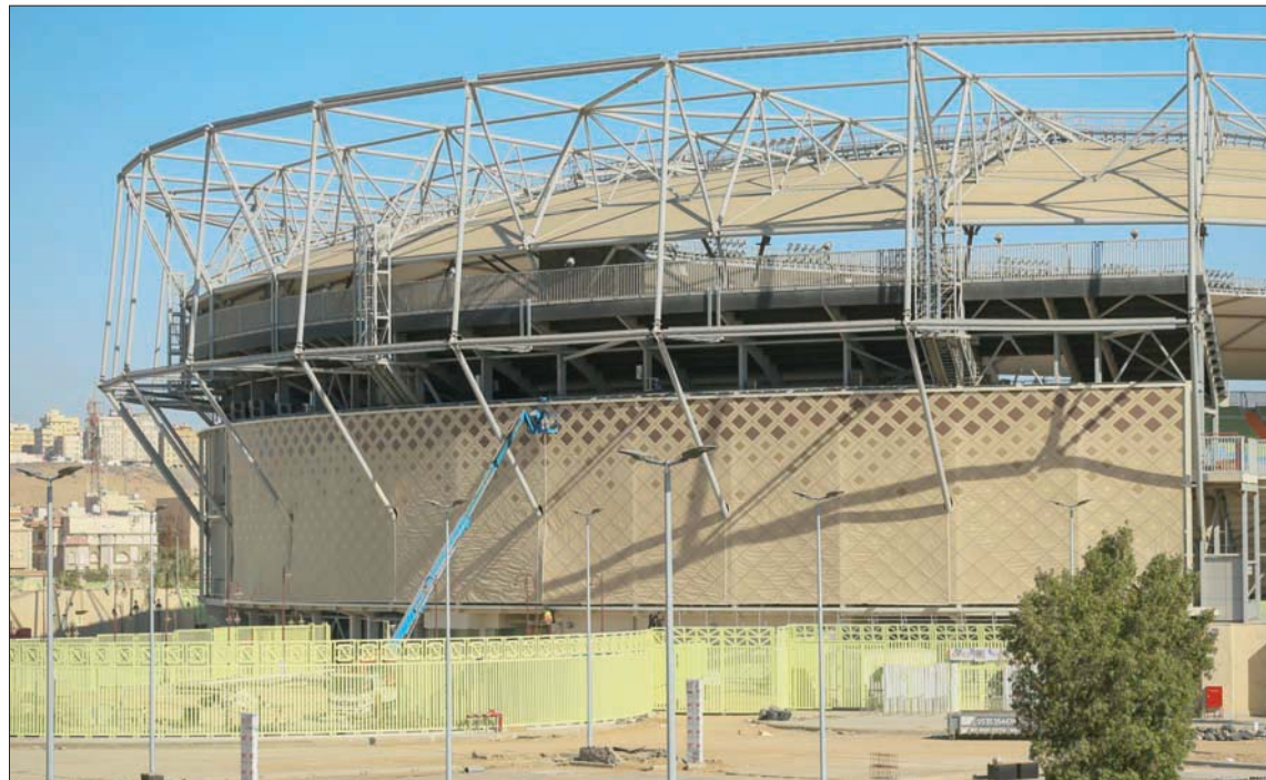
جانب من عمليات تركيب الواجهة في ملعب الفصيل بجدة (تصوير: محمد المانع)
