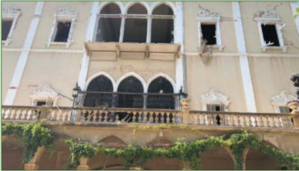
الواجهة الأمامية لقصر سرسوق أصيبت بفعل الانفجار
