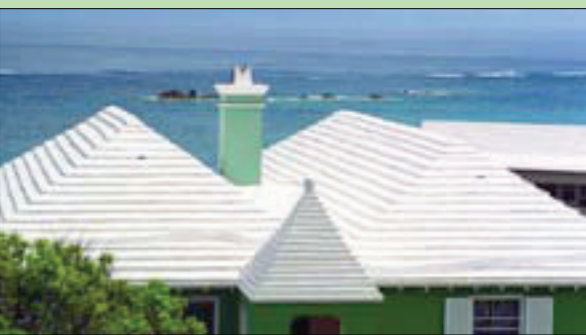
الطلاء يغطي أسطح وواجهات بعض المباني
