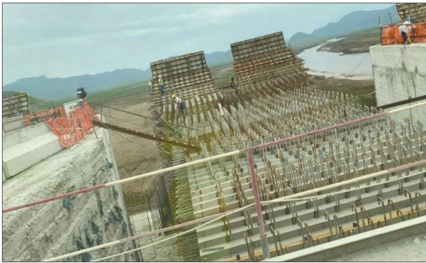
صور حديثة لأعمال البناء بـ«سد النهضة» (صفحة وزير الري الإثيوبي على «فيسبوك»)
