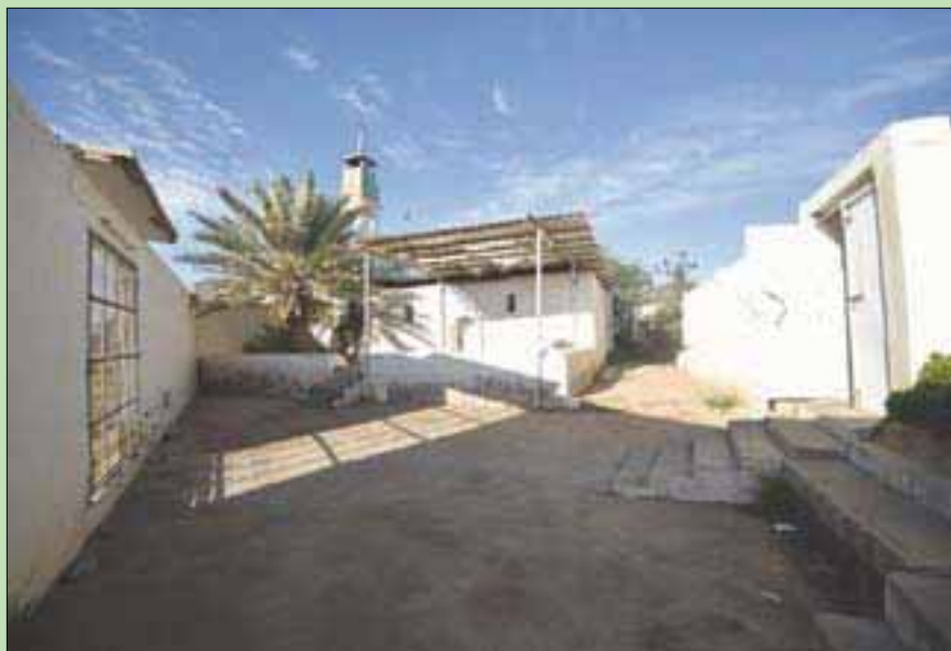
مسجد سليمان قبل الترميم (الشرق الأوسط)
