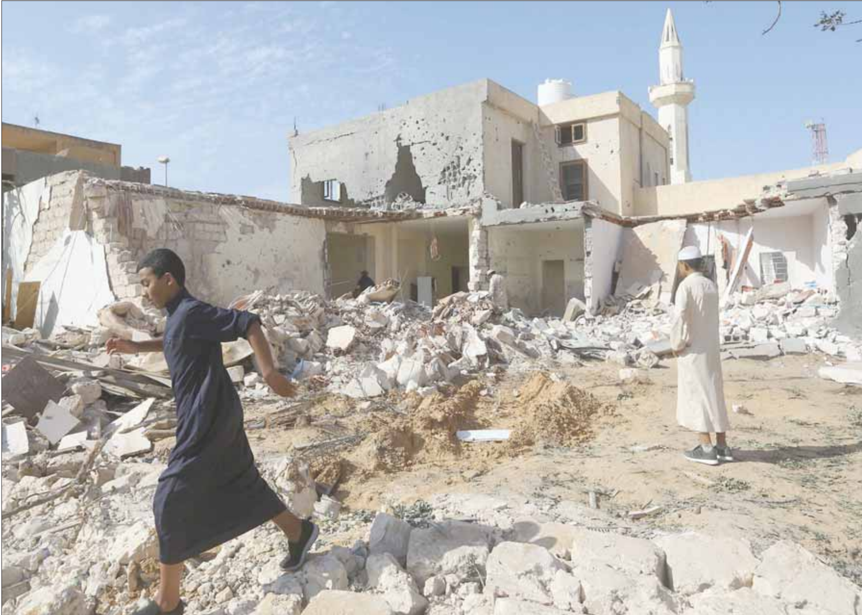
ليبون يعاينون آثار دمار خلفته غارة جوية على طرابلس في 14 أكتوبر أسفرت عن مقتل 3 أطفال (أ.ب)
