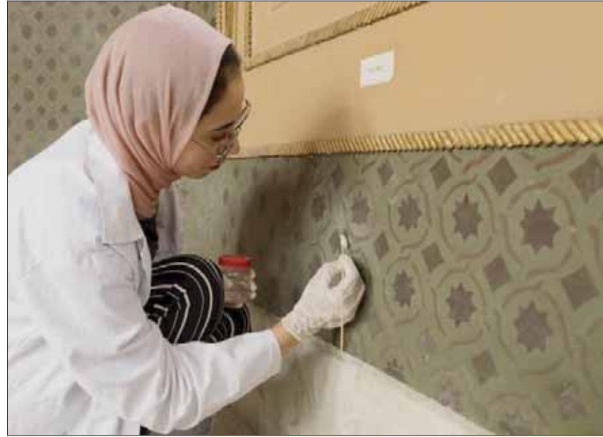
ترميم نقوش وزخارف القصر ضمن مشروع التطوير
