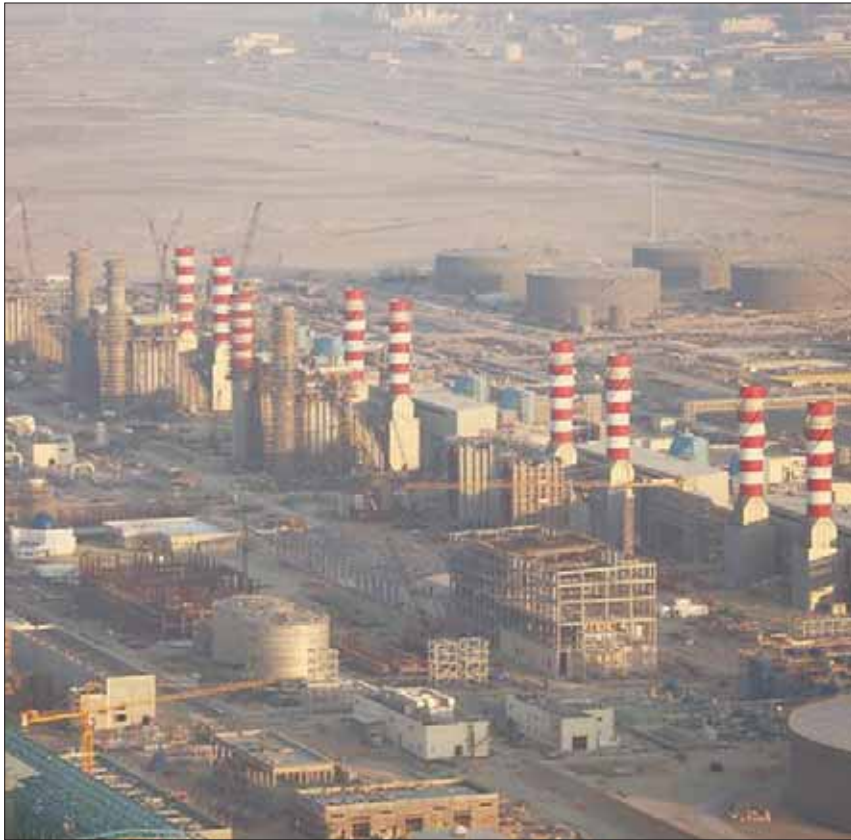
إحدى أكبر محطات توليد الكهرباء في السعودية وتعكس مدى استهلاكها للنفط والغاز (الشرق الأوسط)
