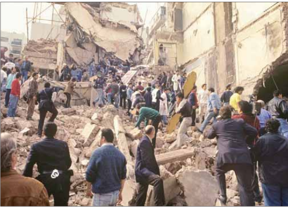
عمال الإغاثة والإنقاذ وأثار الخراب والدمار بعد انفجار شاحنة محملة بالمتفجرات خارج مبنى الجمعية الإسرائيلية - الأرجنتينية في 18 يوليو 1994 في بوينس آيرس (رويترز)
