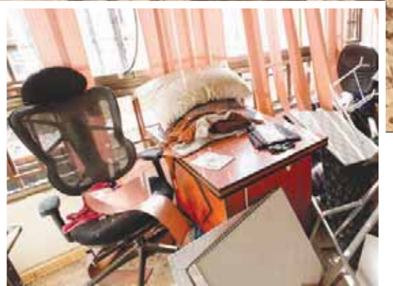
أضرار لحقت بالمكتب الإعلامي لـ«حزب الله» بفعل انفجار الطائرة الإسرائيلية في الضاحية الجنوبية لبيروت فجر أمس (أ.ف.ب)
