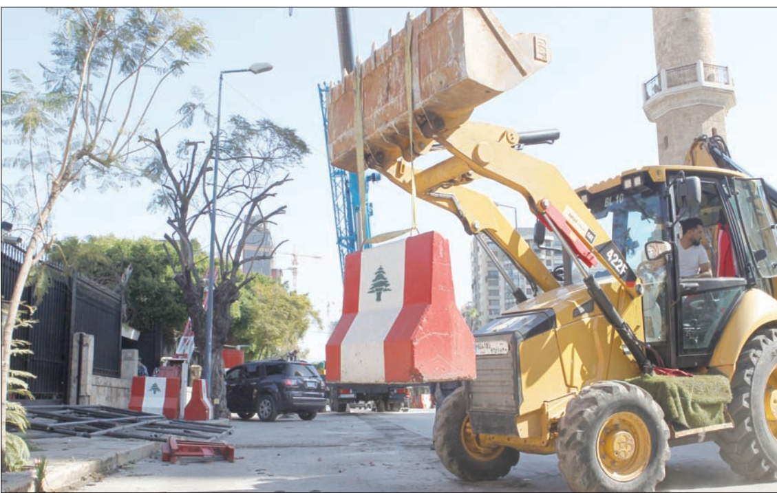
جرافة تزيل حاجزاً إسمنتياً كان موضوعاً أمام مبنى وزارة الداخلية في بيروت (رويترز)
