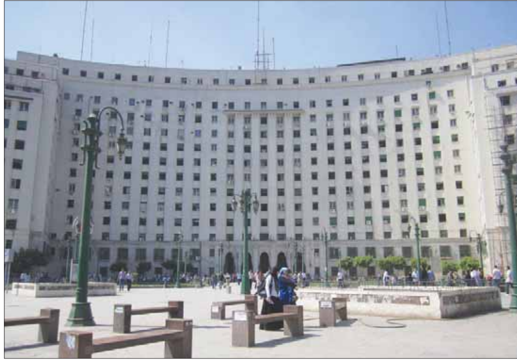
مبنى مجمع التحرير (الشرق الأوسط)
