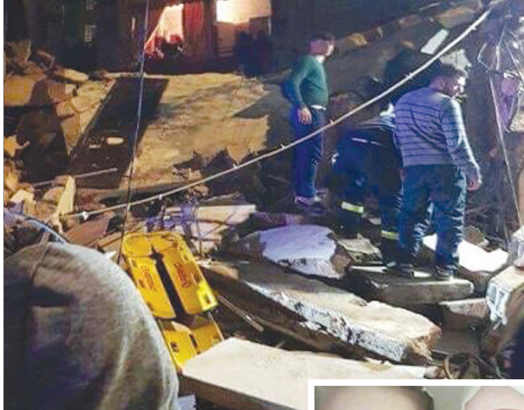
صورة للمبنى المنهار في الضاحية جنوب بيروت أمس تناقلتها وسائل التواصل.. وفي الإطار امرأة وابنتها ضحيتا الانهيار
