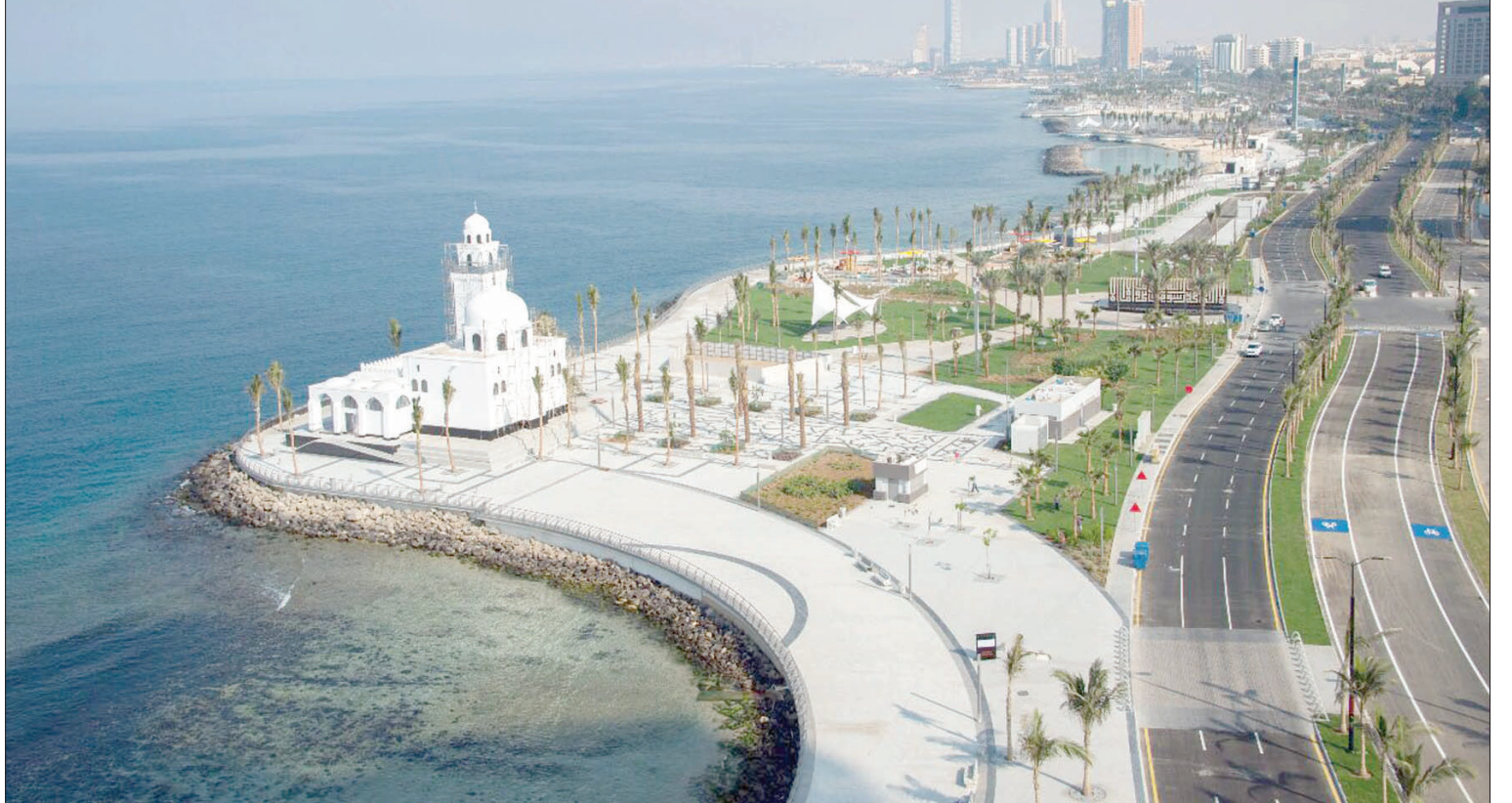
مشروع تطوير الكورنيش الشمالي في جدة بواجهتيه الرابعة والخامسة (جيه دبليو)
