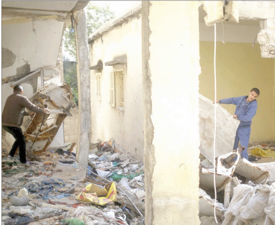
أطفال فلسطينيون يلعبون داخل بناية تعرضت للقصف خلال الحرب الأخيرة على غزة (أ.ب)
