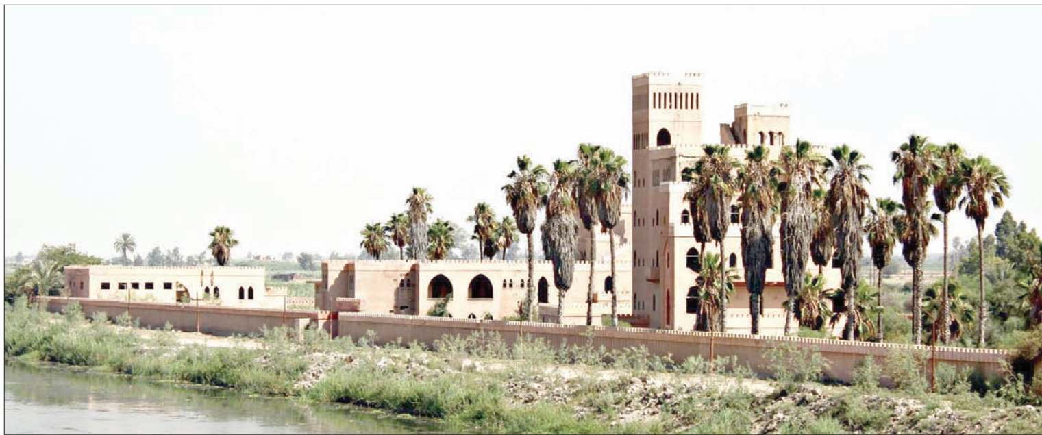
قصر «جناكليس» مبنى تراثي بمدينة أبو المطامير في محافظة البحيرة يحتاج إلى ترميم شامل («الشرق الأوسط»)
