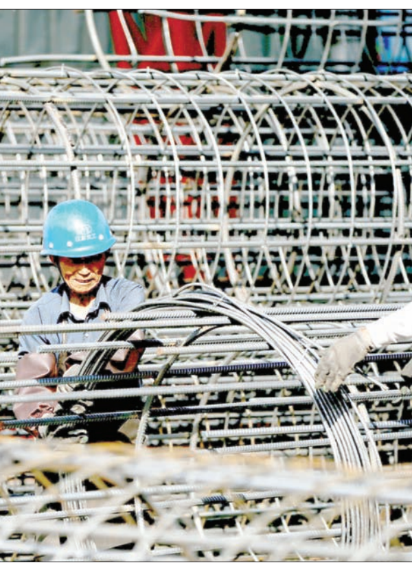
عاملان صينيان يعملان على صنع أقفاص فولاذية لأساسيات البناء في موقع بناء بمحافظة جيانغسو الصينية (رويترز)
