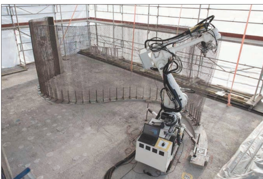
روبوت «ميش مولد» وهو يبني شبكاته الحديدية
